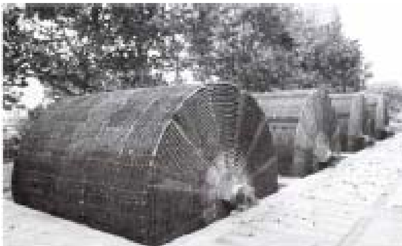
Slika 8-28 Biodiskovi na otvorenom
