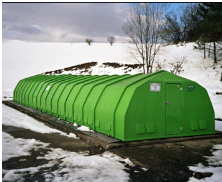
Slika 8-29 Pokriveni biodisk uređaj
